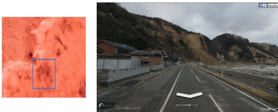
Figure 27. Niemachi Landslide covering a road seen on Google Earth (N. Obushi, 2024)
